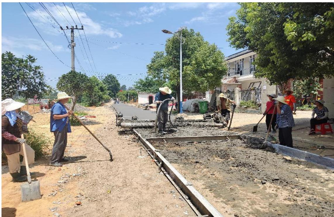
多方支持，全面推动实施。与电力、通信等相关行业部门对接，对影响道路拓宽提质的电线杆 40 余根进行迁移，为民生工程“开道”；村两委多方协调，利用两个月时间，将原 3.5 米土路基全面拓宽至 8 米至 10 米，为道路硬化做好充分准备。多
